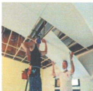
111.11.11 天花板拆除和垃圾清運作業 111.11.13 寢室和客廳天花板作業 111.11.22-11.26 客廳及寢室裝修石塑地板
