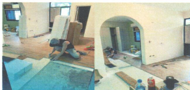
111.11.11 天花板拆除和垃圾清運作業 111.11.13 寢室和客廳天花板作業 111.11.22-11.26 客廳及寢室裝修石塑地板
